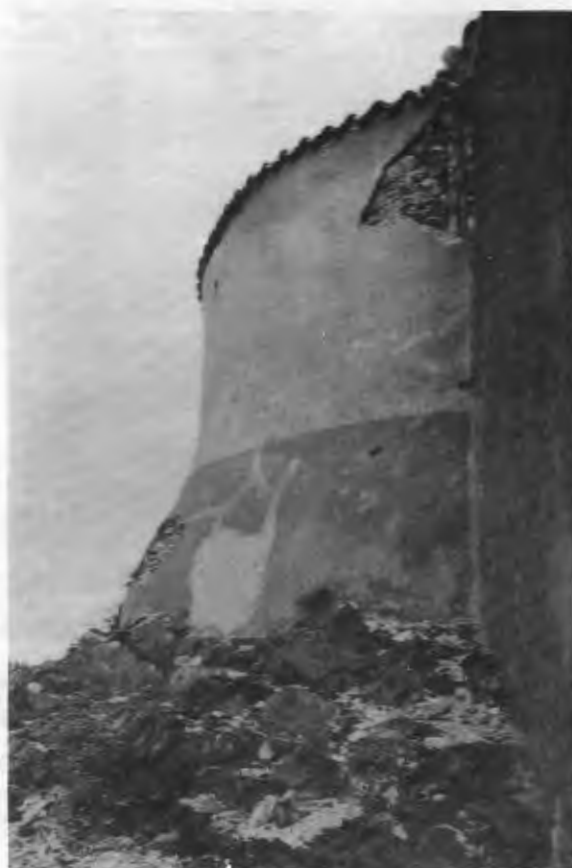
L'abside de la chapelle, ancienne tour à signaux, sera bientôt décrépie. (cl.J.Tosti)
