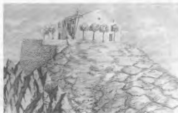
L'ermitage en 1859, après d'importants travaux.
