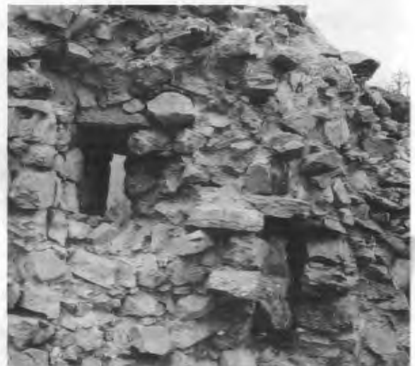
Archères du château de Roquevert (cl. J. Tosti)
