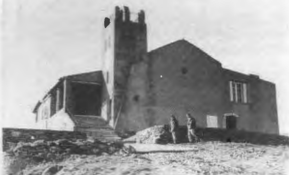
L'ermitage ces dernières années : on y remarque le clocher rajouté vers les années 1930.
