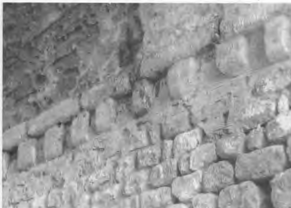
La corniche soutenue par des corbeaux (cl. J. Monier)
